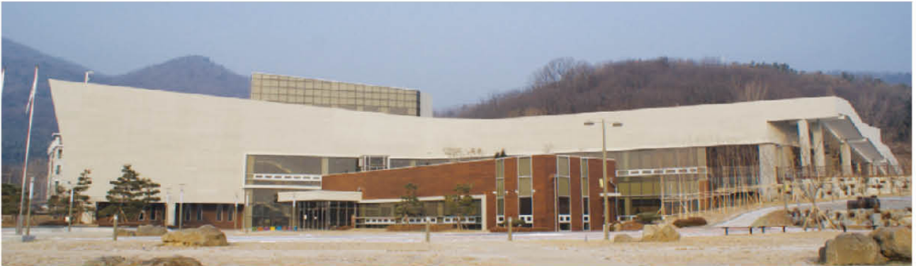
남양주 유기농 박물관 전면 시공
