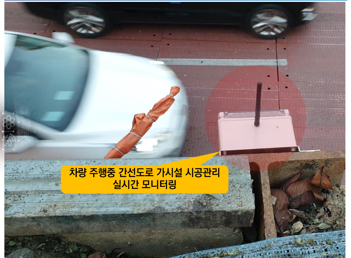
서부간선도로 지하화 개착구간 가시실 실시간 모니터링
