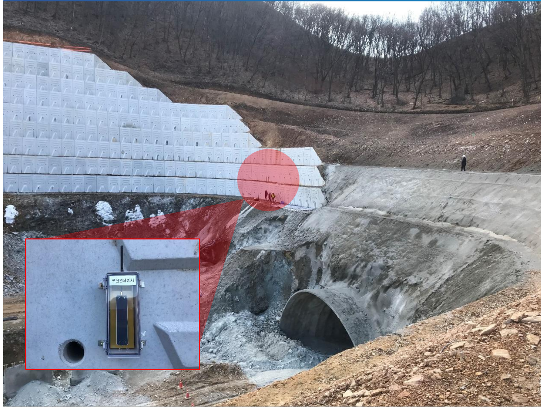
제2외곽순환고속도로 터널 갱구부 옹벽
