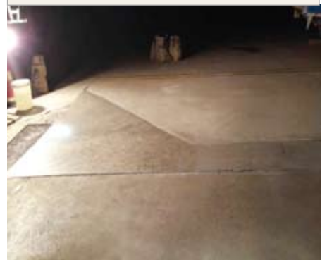
공항 바닥 보수
