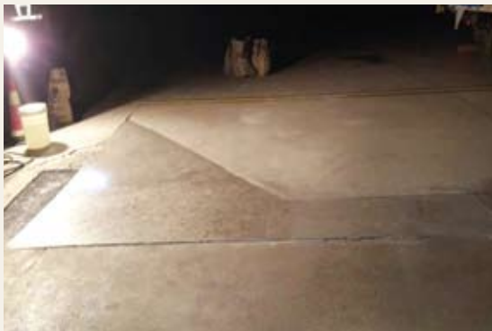
공항 바닥 및 해안가 보수공사
