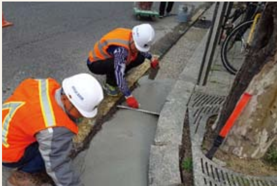
L형 측구 보수공사
