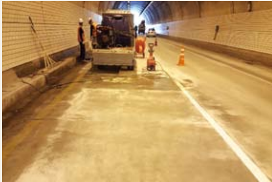
고속도로 및 교량 보수공사
