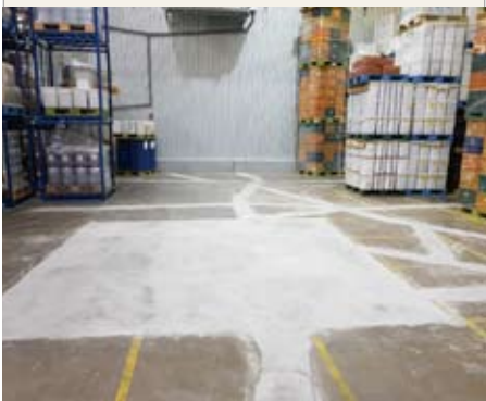
냉동창고 바닥 보수
