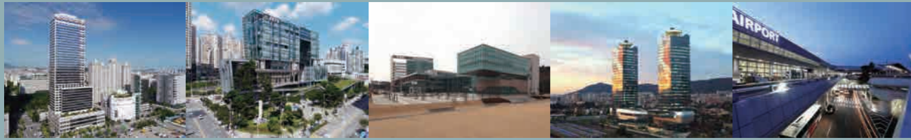
현대 41타워 금천구 종합청사 인천국제공항공사 인재개발원 한국철도시설공단 대전사옥 제주국제공항 여객터미널
