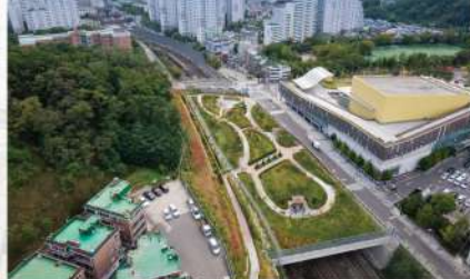
+ 백운역 철도변 생태공원조성사업 Beam Launcher+IPC, L=8@20m=160m
