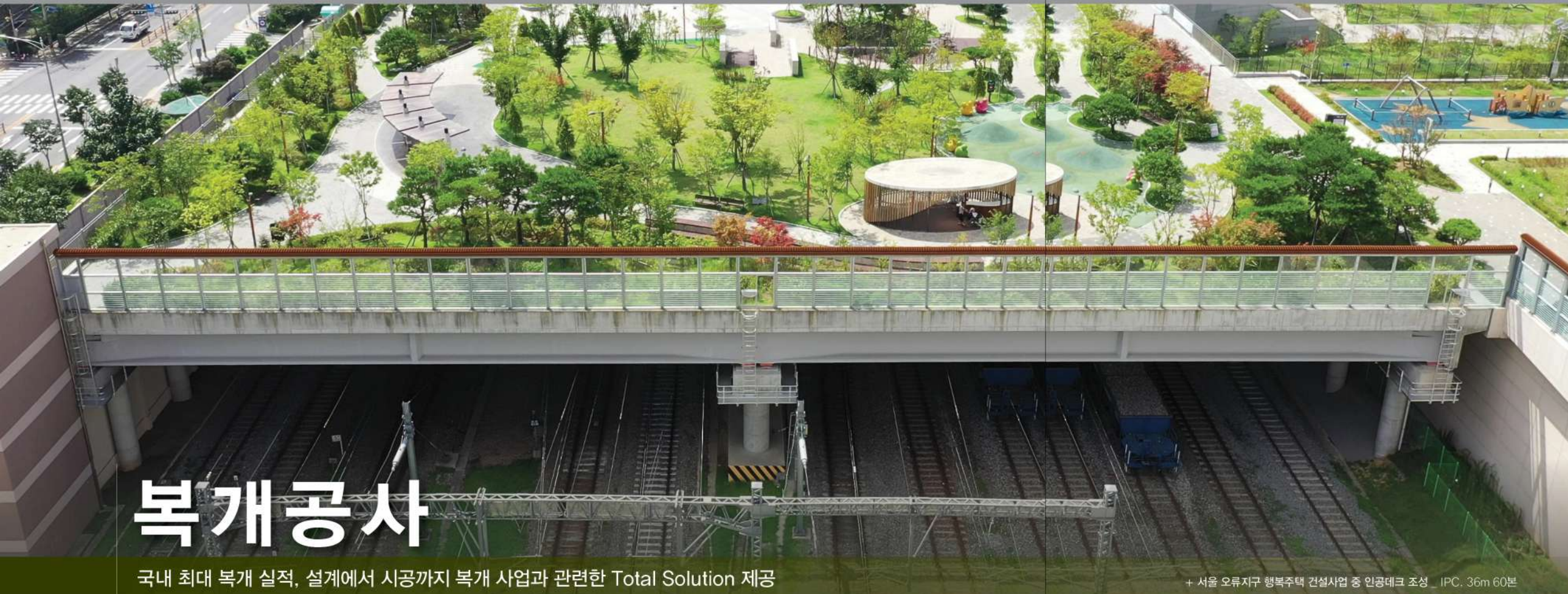
+ 백운역 철도변 생태공원 조성사업 (Beam Launcher 시공) _ IPC. L=30m~40m, B=140m
