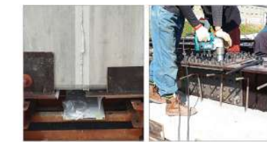
케이싱 콘크리트 접합 상부, 복부 볼트체결
