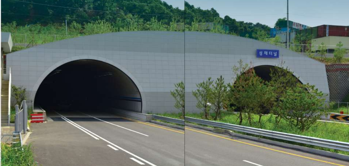
+ 수원~광명 고속도로 중 성채터널 _ SegArch L=40.85m
