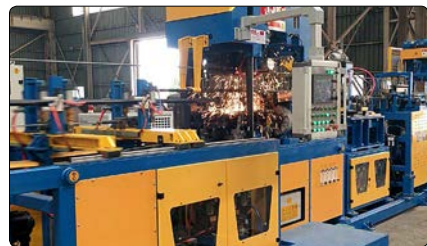
❹ 선재 1차 밴딩 및 용접
