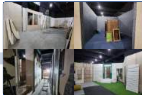
설계에 따른 제품 설치 | 빈 공간에 세트장 설치
