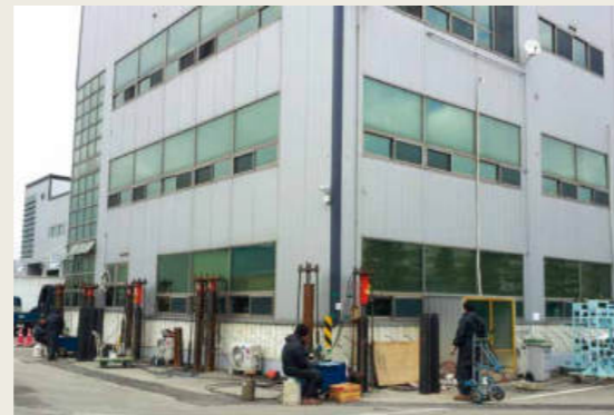
건물 외부 작업
