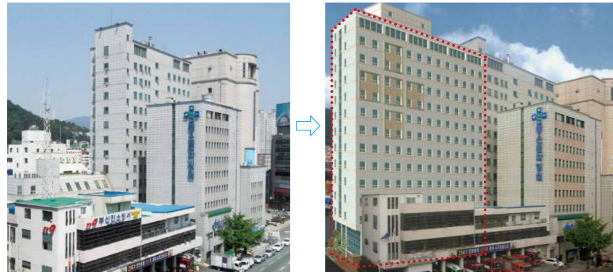
기존 지하 1층~지상 5층 병원을 지하 2층~지상 14층으로 상/하 증축
