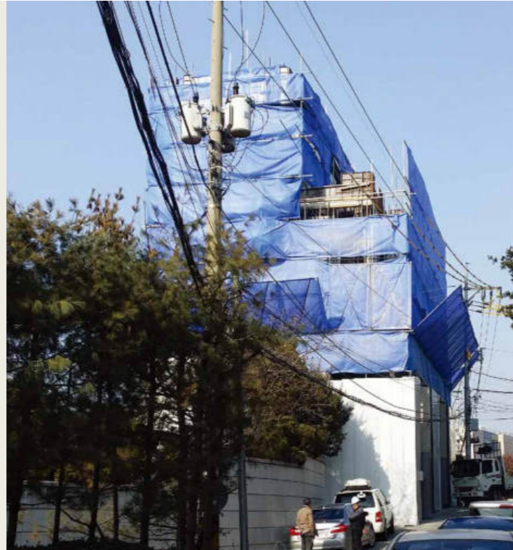
경사 성토지반에 신축 공사 중
