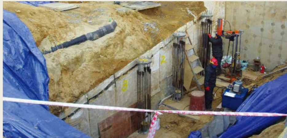
시공 중 | 팽이기초보강 침하 공동구 말뚝 기초보강
