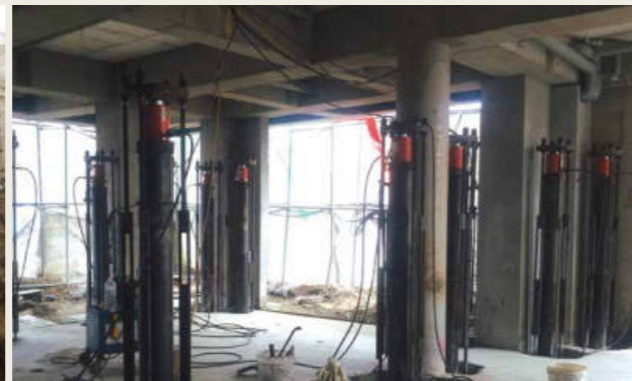
말뚝 압입 시공 중
