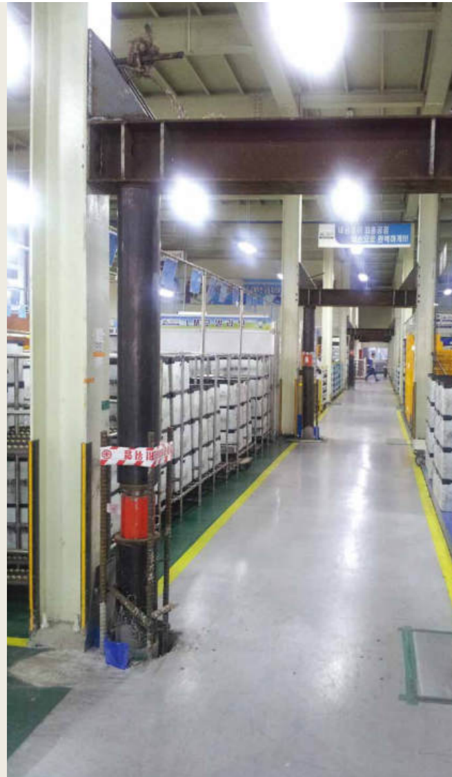
2차 공사 | 자동차부품 공장 가동 중 기초보강
