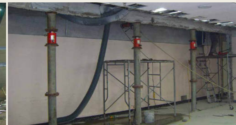
시공 중 | Jack-up 파일로 지지하며 철거
