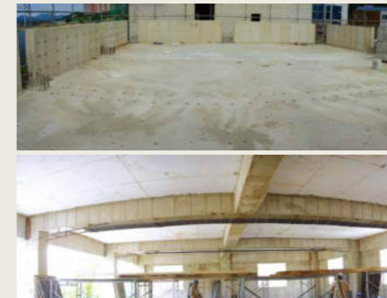
시공 후 | 슬래브 위아래
