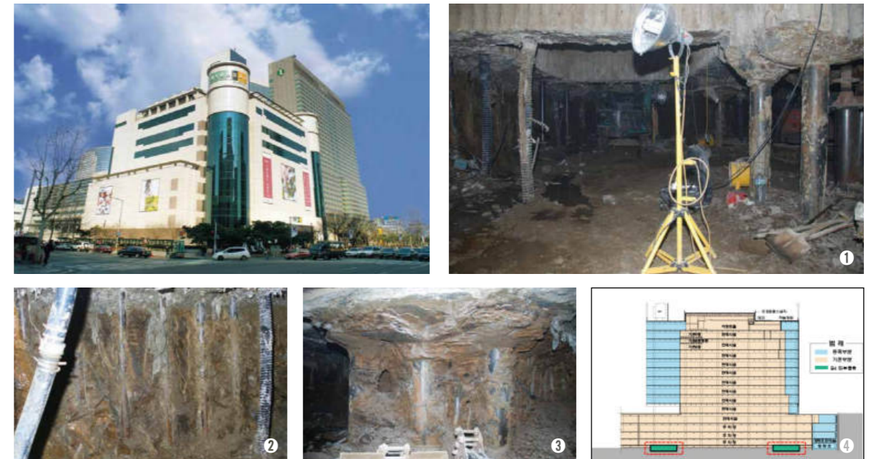
① B4층하부굴착상태 ② 강관네일토류벽 ③ 160톤가압말뚝압입된상태 ④ 엘리베이터기초지하증축
