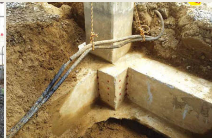
전단철근을 보강하여 단면중설한 후 기초보강
