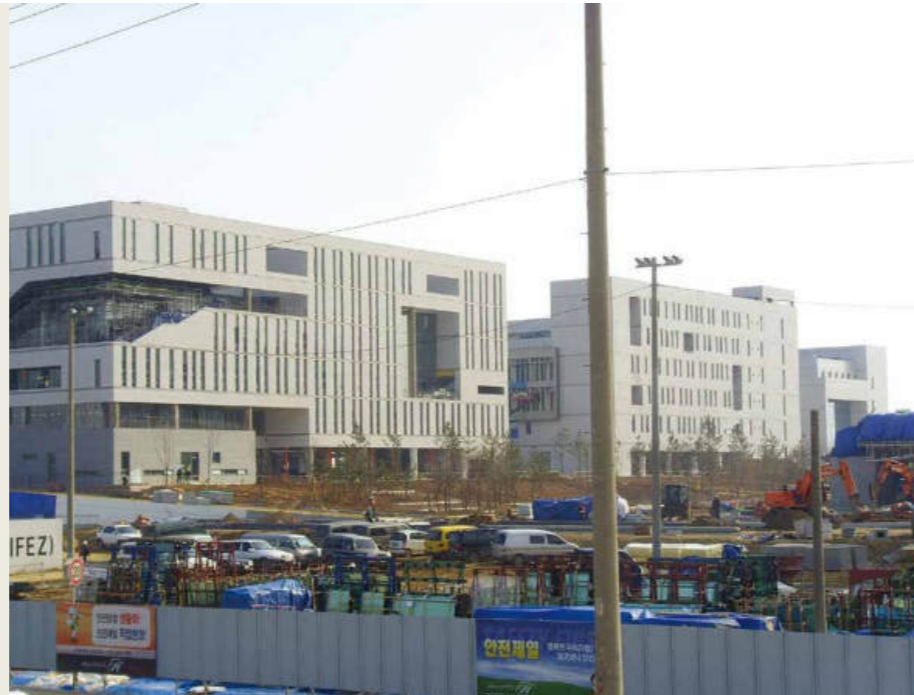
신축 중 건물 전경
