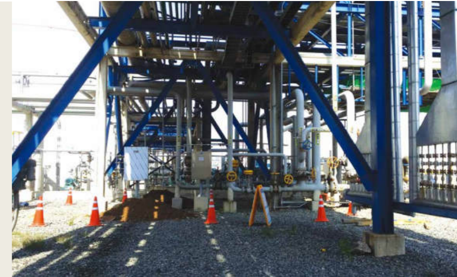
Pipe Rack 기초보강 위치 현황
