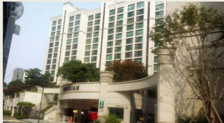
엘리베이터 지하증축 리모델링 후
